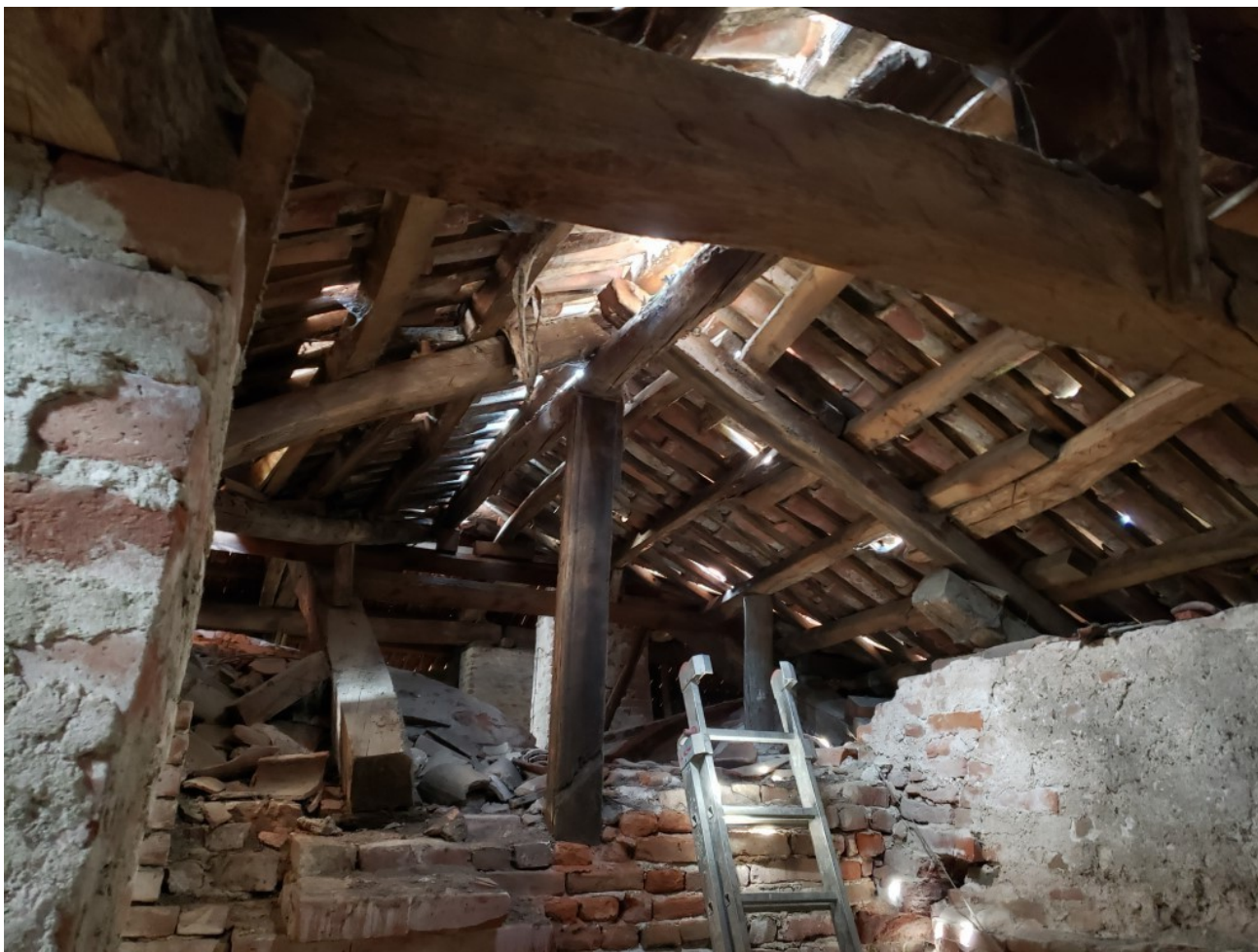
Foto 11 Abbaino di occidente, innesto della manica dei “Ricostruttori” alla manica delle celle dei monaci; è evidente la precarietà del sistema tetto, con pilastri in semplice appoggio, mutua connessione per attrito e semplice appoggio sulla muratura dei puntoni.
