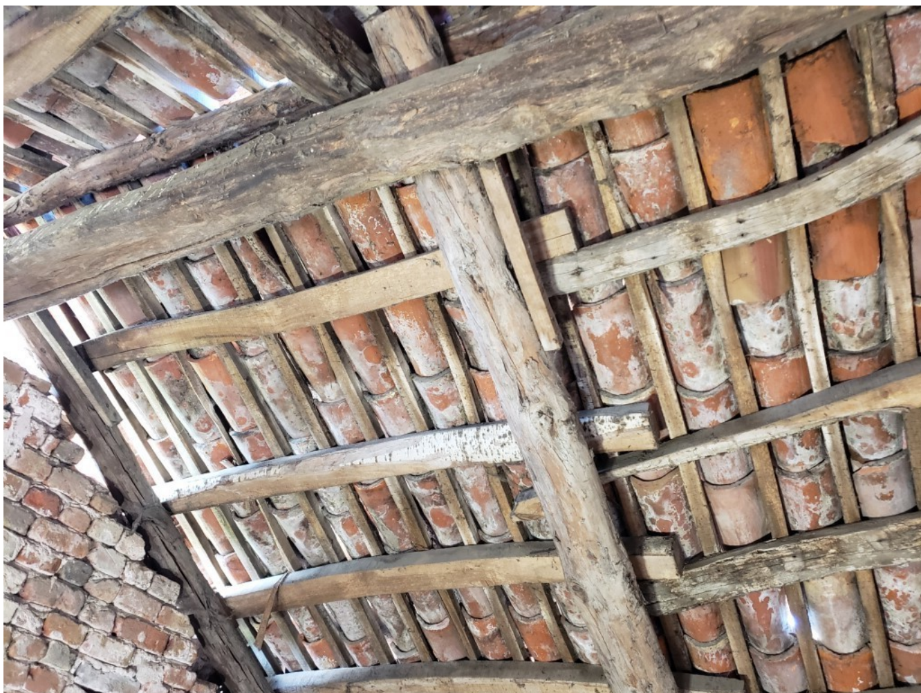
Foto 7 – Foto interna della grossa orditura del tetto; trave al colmo, punter, ordito medio e secondario.
