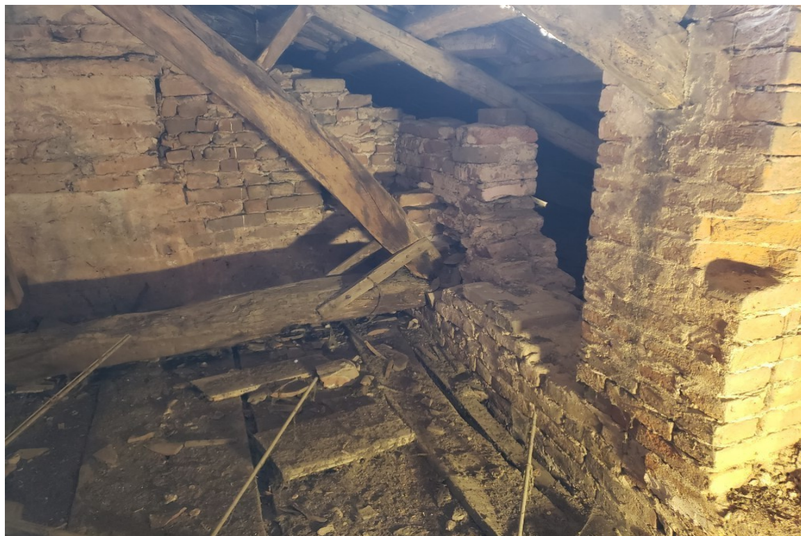
Foto 14 Durante la realizzazione della copertura per sopperire al cambio di sagoma della pianta della manica dei Ricostruttori si è realizzata una capriata zoppa, col tempo si è verificato un parziale svergolamento di essa, dovrà essere ripristinata a piombo.
