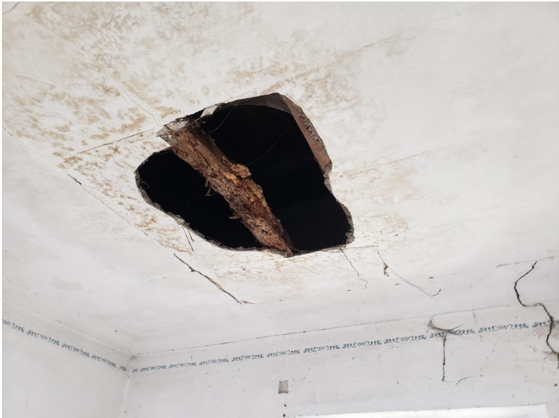
Foto 16 Solaio di sottotetto nella stanza in prossimità del pozzo. È la zona più deteriorata a causa delle infiltrazioni delle acque meteoriche.
