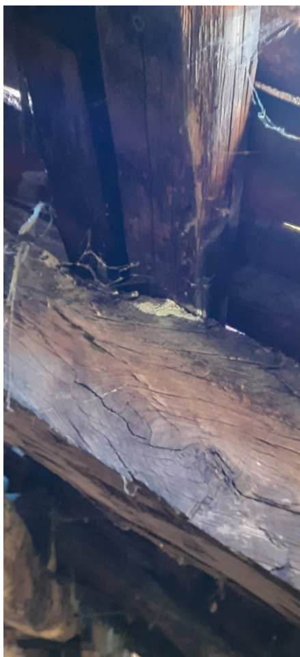
Foto 9-10 Due esempi di grossa orditura in cui si vede l'aggressione di acqua e funghi causandone anche lo schiacciamento di alcuni elementi
