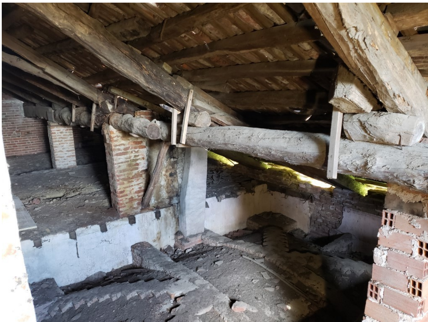
Foto 12 Tratto della copertura sopra la Sala Rossa: si evidenzia il sistema di appoggi puntoni banchina con spessoramento eseguito con spezzoni di vecchie travi tagliate uso Fiume, appoggio precario e ad alto rischio di scivolamento.
