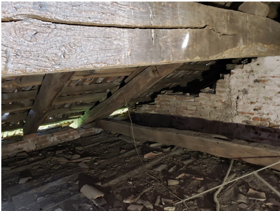
Foto 13 Molte travi, specie le banchine che risultano molto caricate, presentano fratture o fessurazioni
