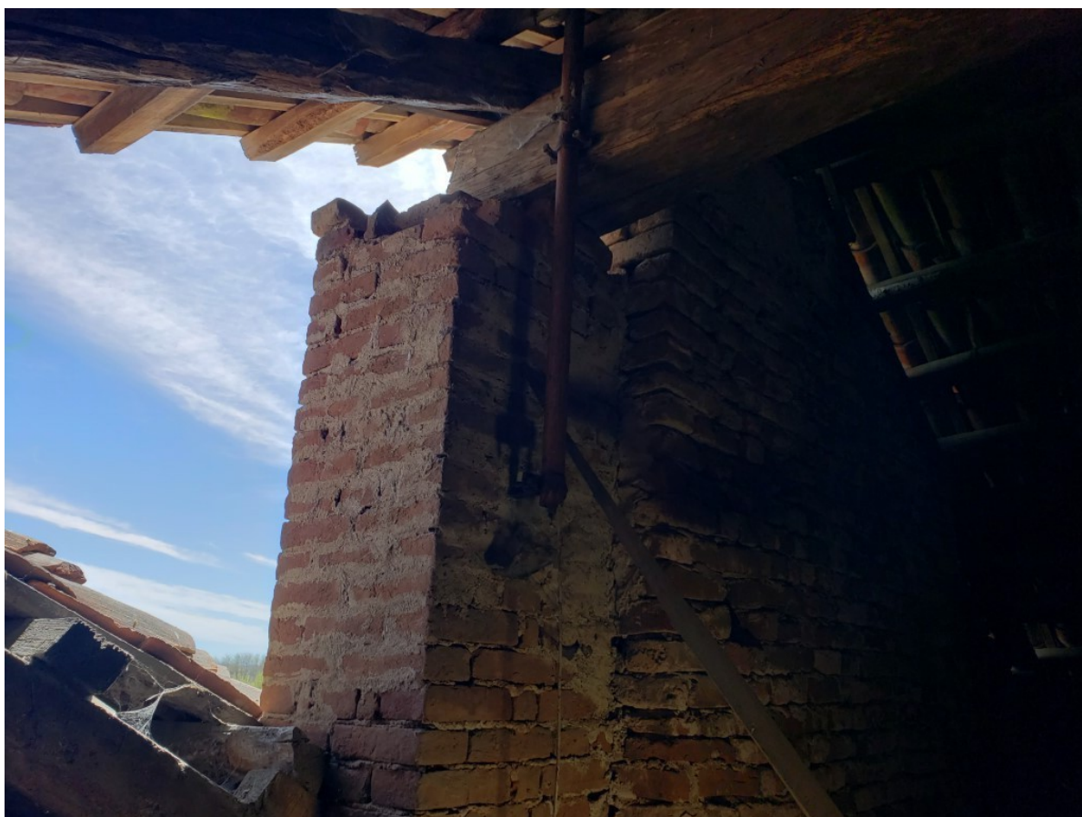
Foto 15 Al di sopra della capriata precedentemente descritta vi è questa apertura con totale assenza di protezione dalle acque meteoriche.
